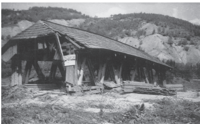
Wielka powódź, lipiec 1934 r. Ostatni austriacki most zadaszony z Krościenka spłynął Dunajcem i po opadnięciu wody osiadł w Zabrzeży. Fot. Władysław Huza
