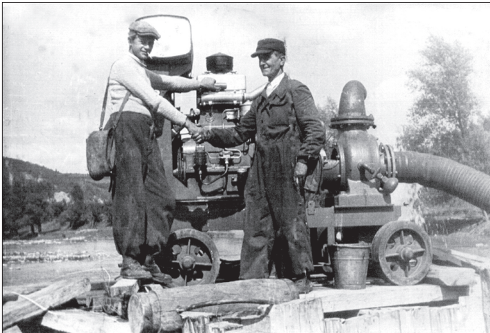
Budowa mostu w Zarzeczu z prawej Wawrzyniec Gałysa z Zabrzeży – operator pomp. (Ze zbiorów rodziny Gałysów z Łącka)
