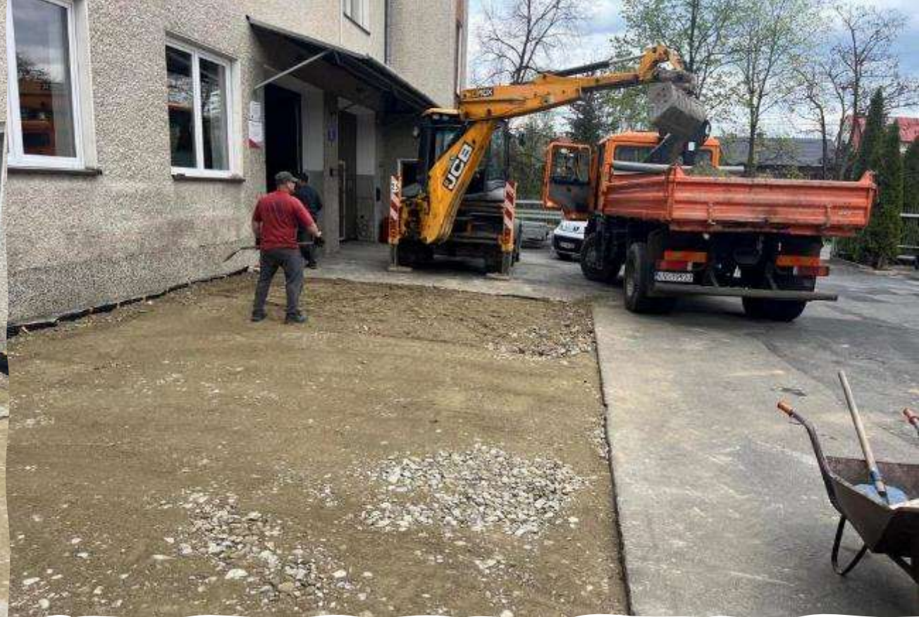
Prace ziemne przygotowawcze do wykonania nawierzchni przy remizie OSP w Łącku
