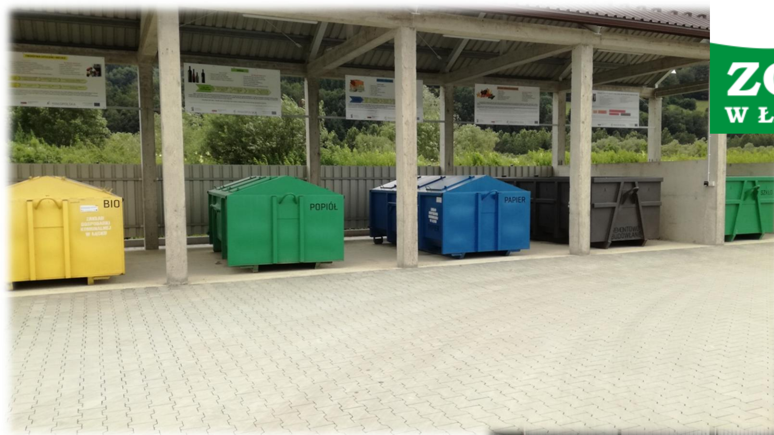
Kontenery KP 7 na bioodpady, popiół, papier i tekturę, odpady budowlane, poremontowe, szkło, odpady wielkogabarytowe.
