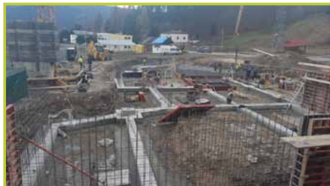
Plac budowy Centrum Kultury i Edukacji Muzycznej w Łącku
