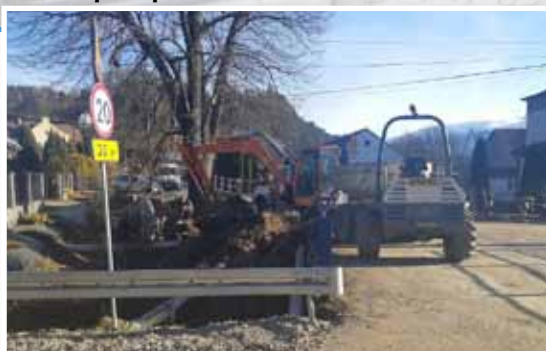
Budowa wodociągu w Maszkowicach
