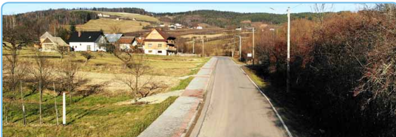
Nowo wykonany odcinek chodnika dł. 380 mb (wraz z kanalizacją deszczową) przy drodze powiatowej Łącko – Kicznia. Łączna wartość inwestycji 338 093 zł; współfinansowany w 44% przez Powiat Nowosądecki i w 56% przez Gminę Łącko.
