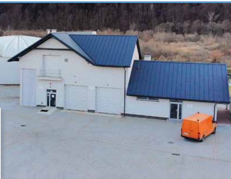
Oczyszczalnia ścieków w Łącko
