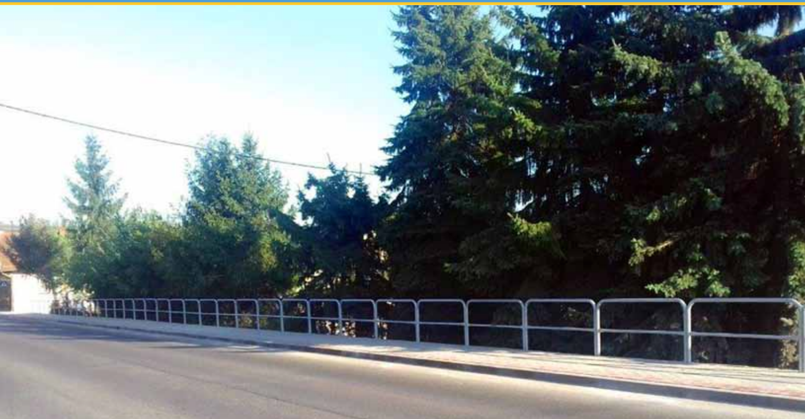
Chodnik przy DW 969 w Łącku
