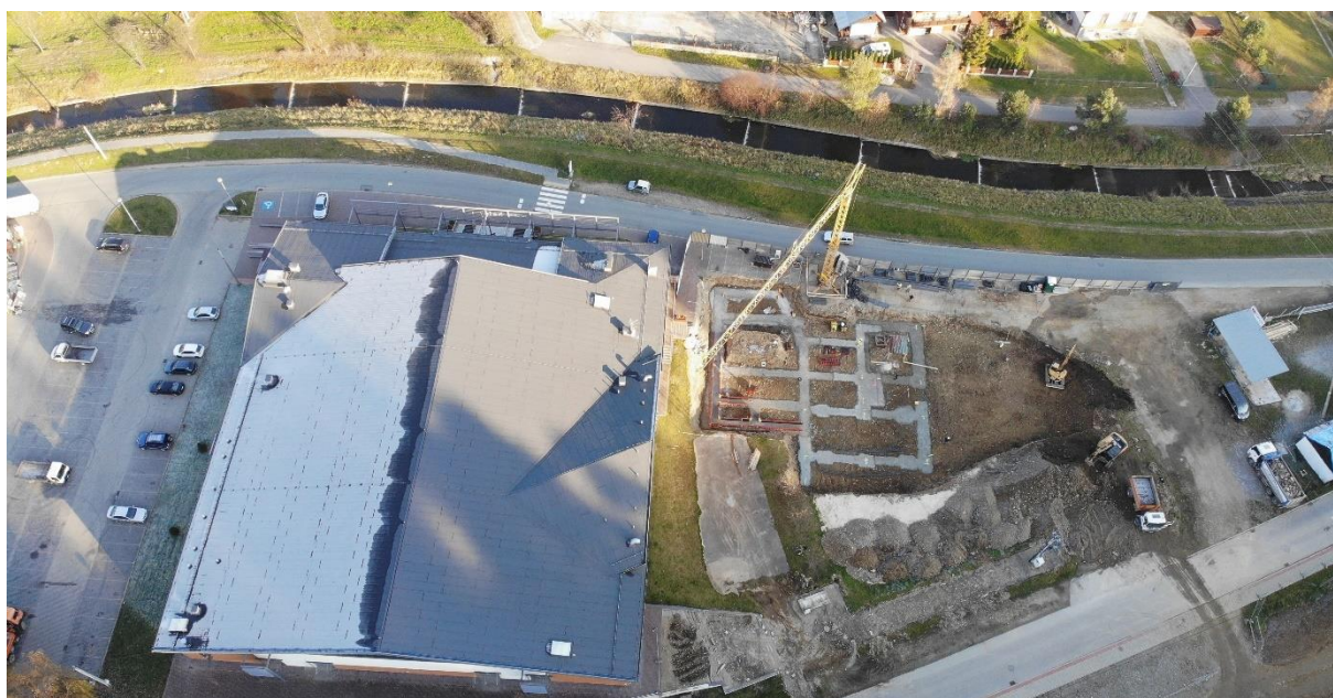
Zdjęcie 16 - Plac budowy Centrum Kultury i Edukacji Muzycznej w Łącku
