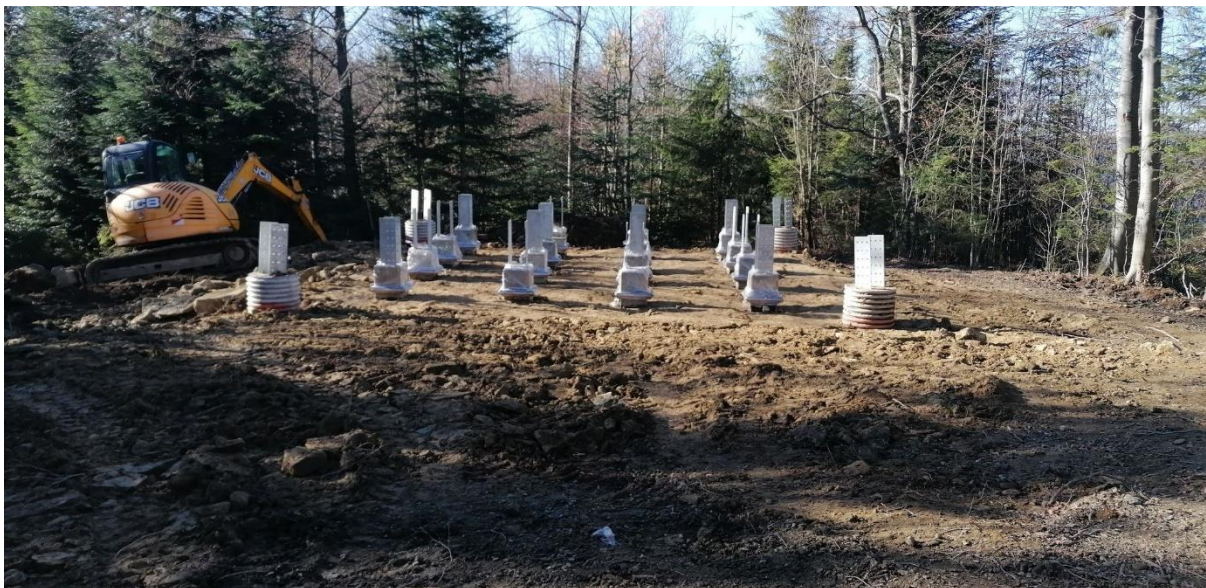
Zdjęcie 12 – Budowa wieży widokowej na Górze Modyń
