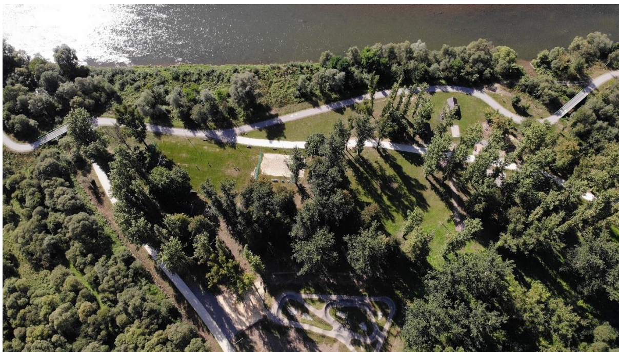
Zdjęcie 8 - Widok z drona na infrastrukturę nad Dunajcem w Łącku
