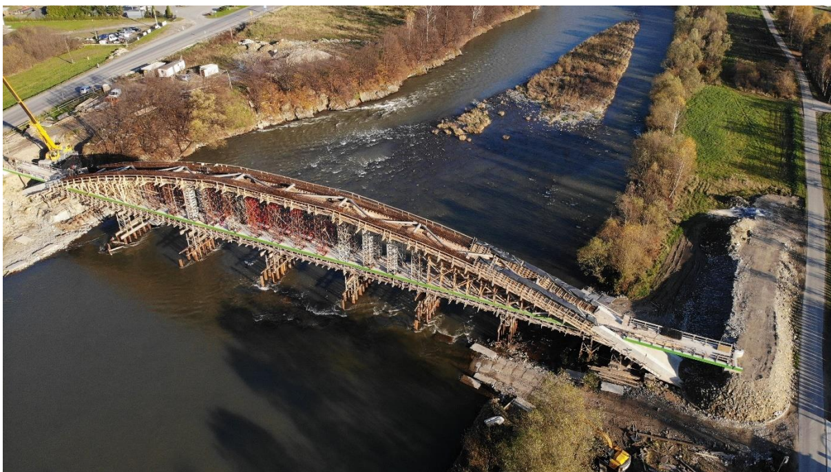
Zdjęcie 10 - Kładka pieszo-rowerowa w miejscowości Zabrzeż - w trakcie budowy
