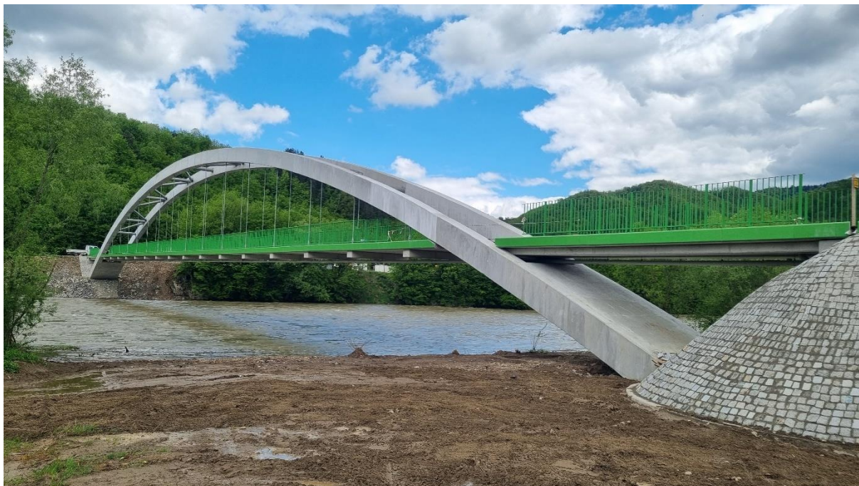
Zdjęcie 11 - Kładka pieszo-rowerowa w miejscowości Zabrzeż
