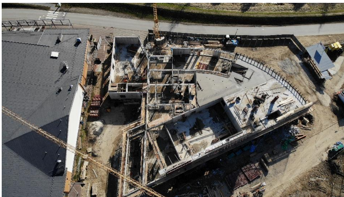
Zdjęcie 17 - Aktualny widok placu budowy Centrum Kultury i Edukacji Muzycznej w Łącku
