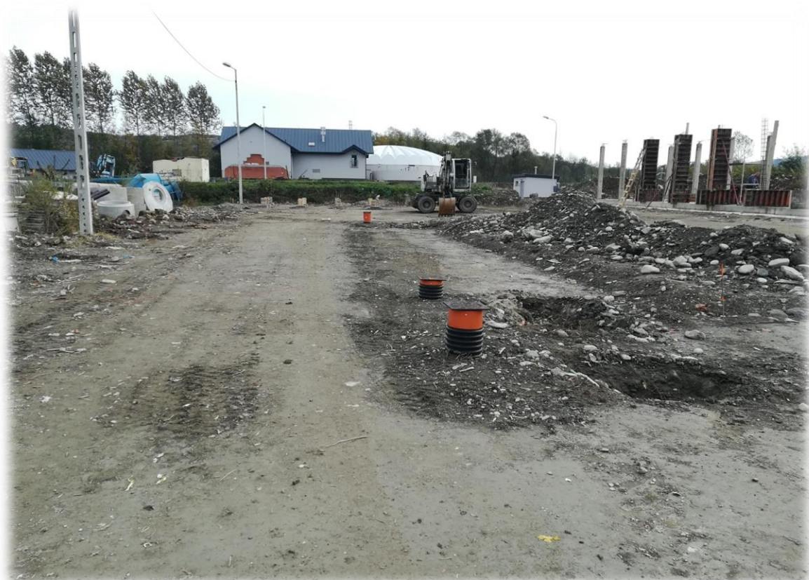
Zdjęcie 20 - Plac budowy Punktu Selektywnego Zbierania Odpadów Komunalnych w Łącku
