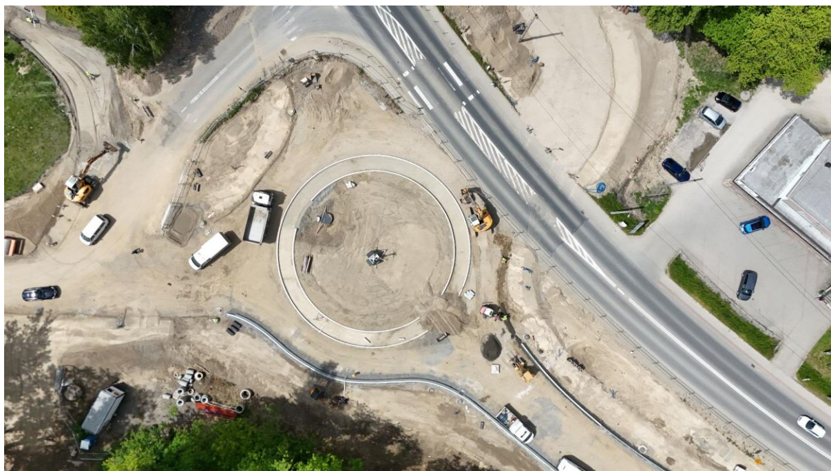
Zdjęcie: Budowa ronda w Jazowsku
