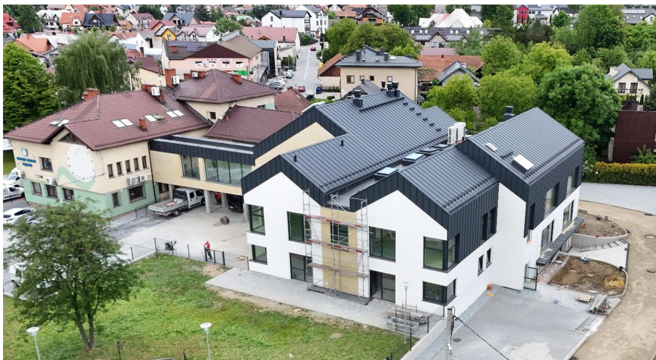
Zdjęcie: Budowa Przedszkola samorządowego wraz ze żłobkiem i częścią administracyjną urzędu gminy.
