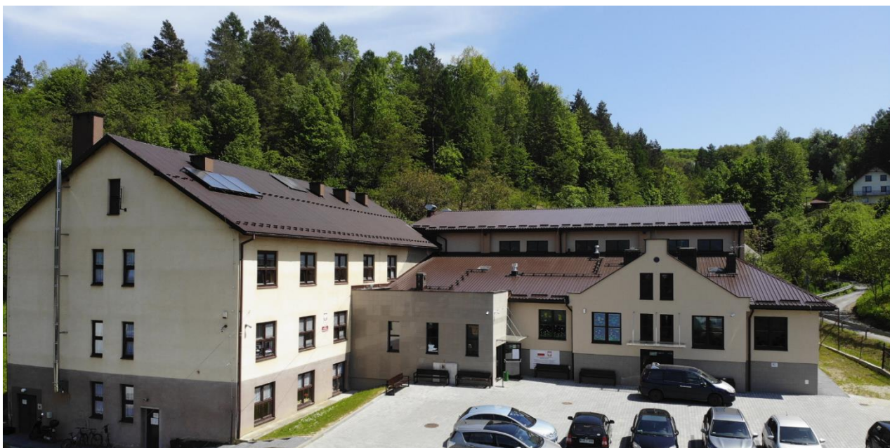
Nowa sala gimnastyczna wraz z dodatkowymi salami lekcyjnymi przy Szkole Podstawowej w Maszkowicach
