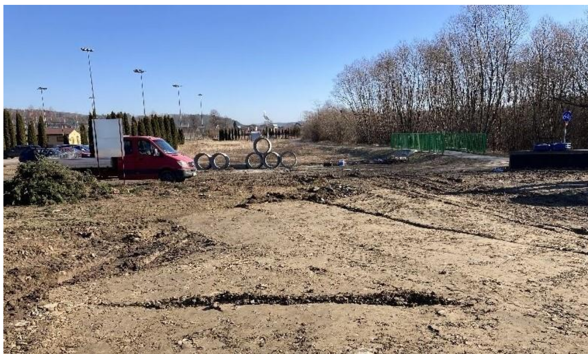
Plac przed rozpoczęciem budowy PSZOK w miejscowości Jazowsko
