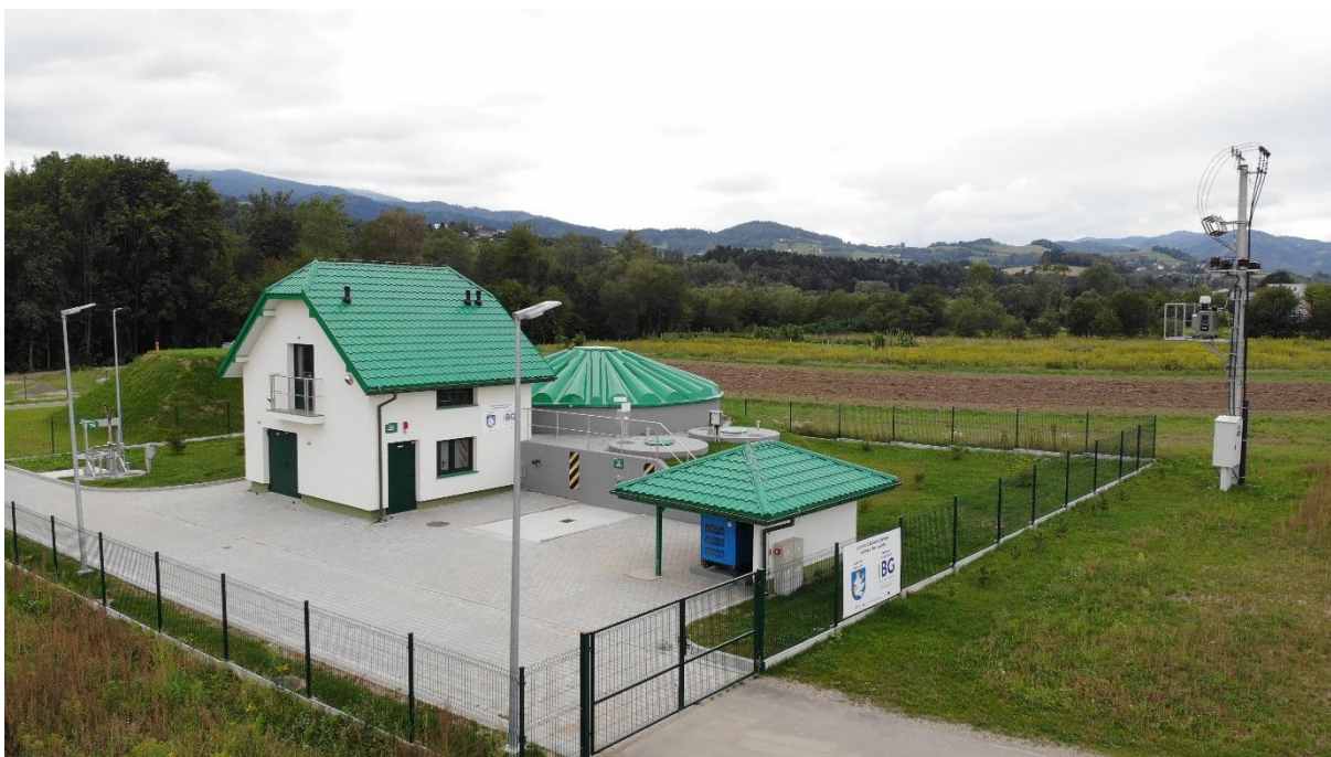
Zrealizowana inwestycja oczyszczalni ścieków w miejscowości Kadcza
