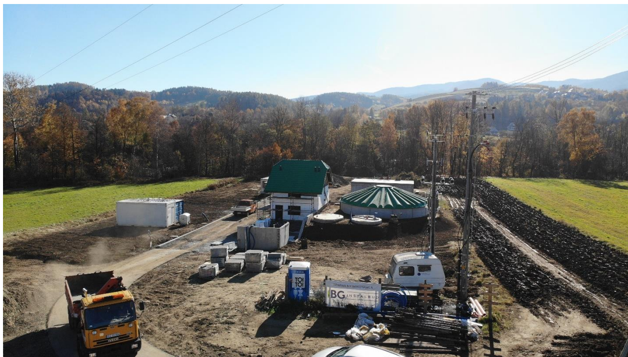
Plac budowy oczyszczalni ścieków w miejscowości Kadcza
