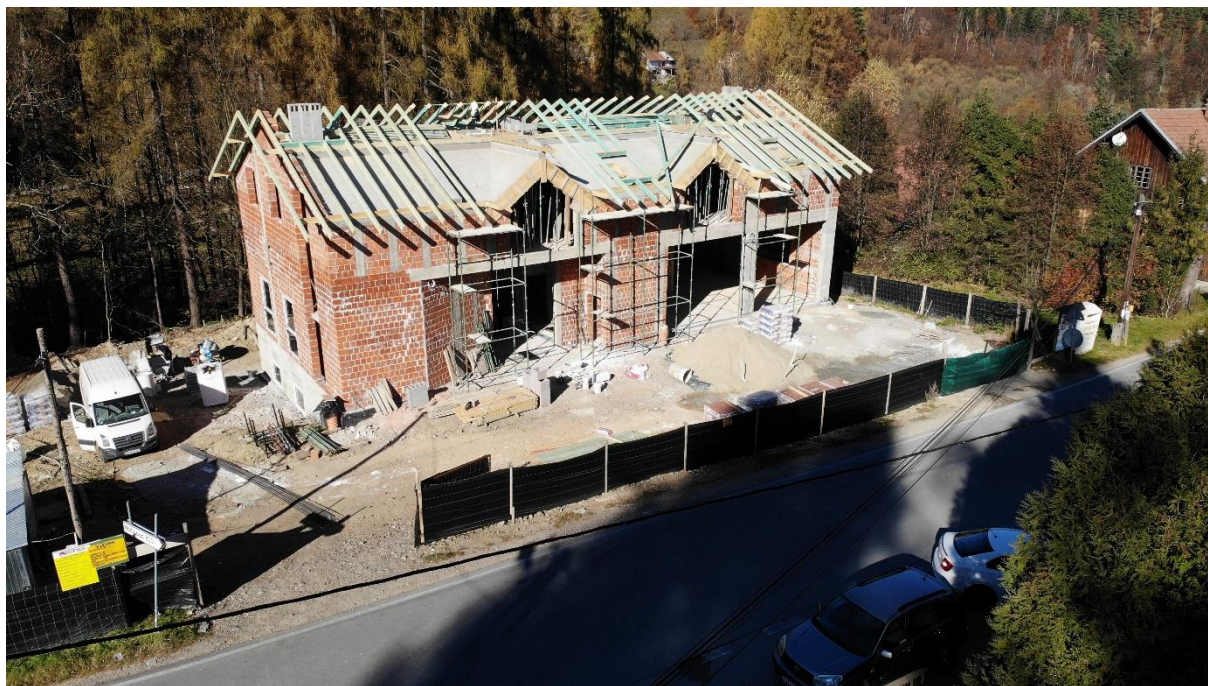
Plac budowy budynku wielofunkcyjnego w Obidzy
