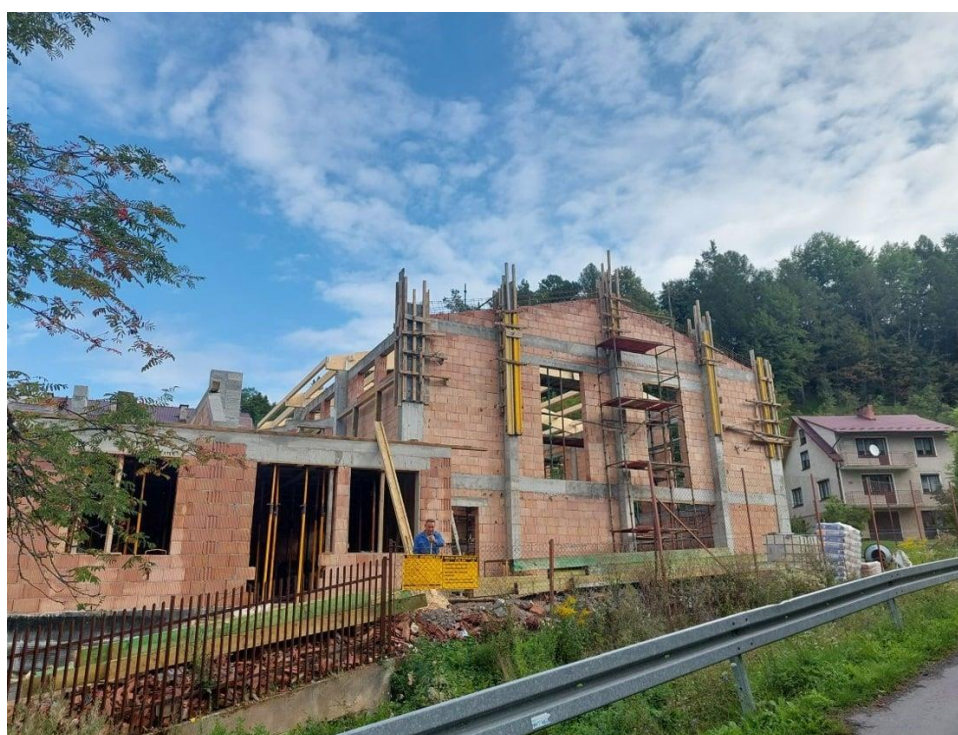
Plac budowy budynku sali gimnastycznej z zapleczem oraz dodatkowymi salami lekcyjnymi i przewiązką przy Szkole Podstawowej w Maszkowicach
