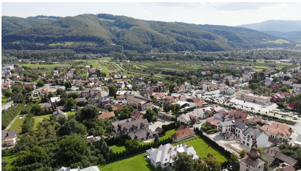
Widok na centrum Łącka
