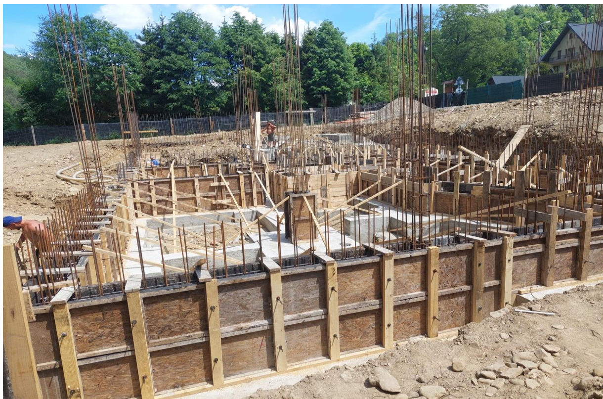
Plac budowy budynku wielofunkcyjnego w Obidzy
