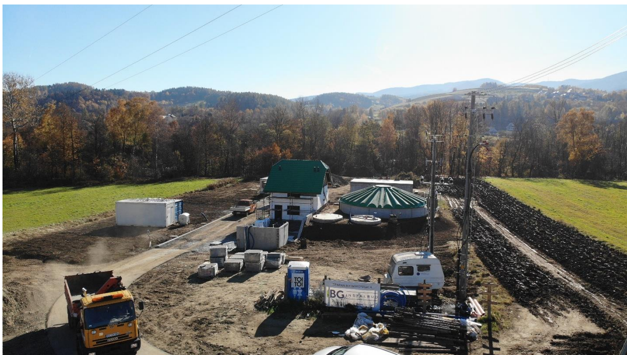
Plac budowy oczyszczalni ścieków w miejscowości Kadca
