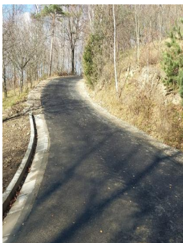
Droga - Brzyna – Przez Wieś
