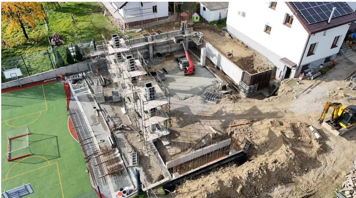
Budowa zadaszenia boiska szkolnego w Szczereżu
