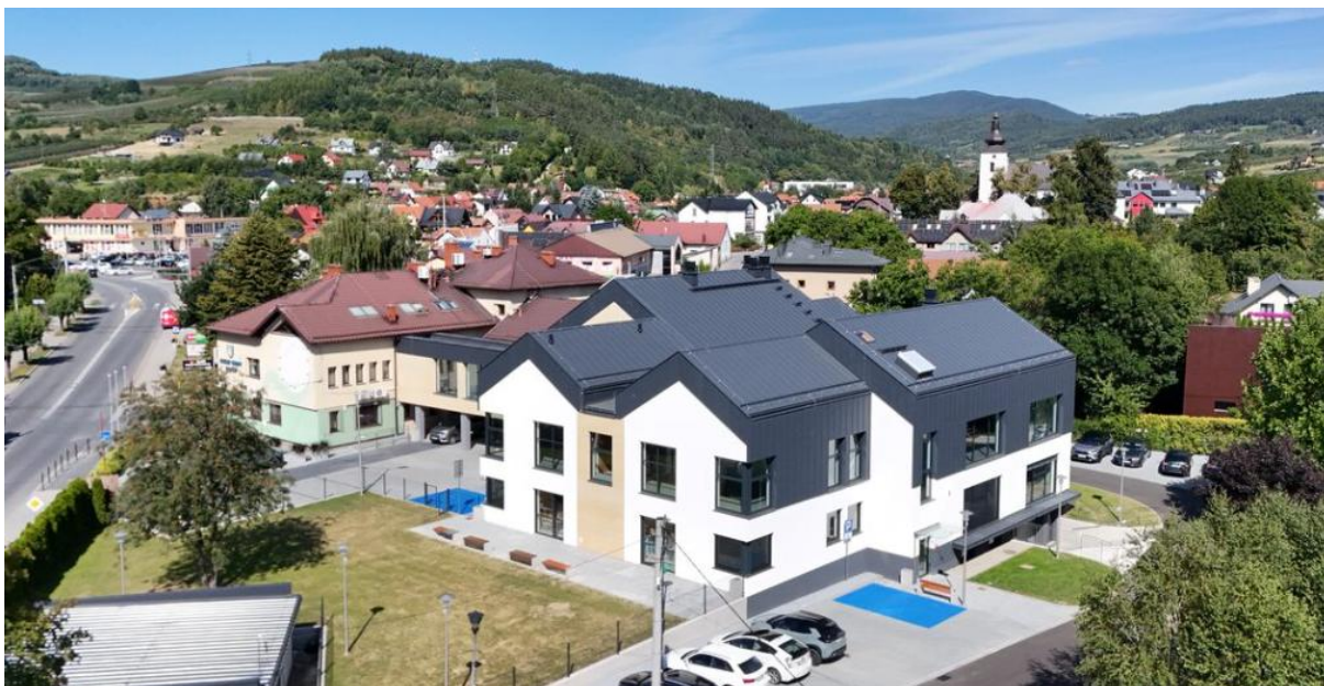
Nowy budynek Przedszkola Samorządowego i Żłobka w Łącku
