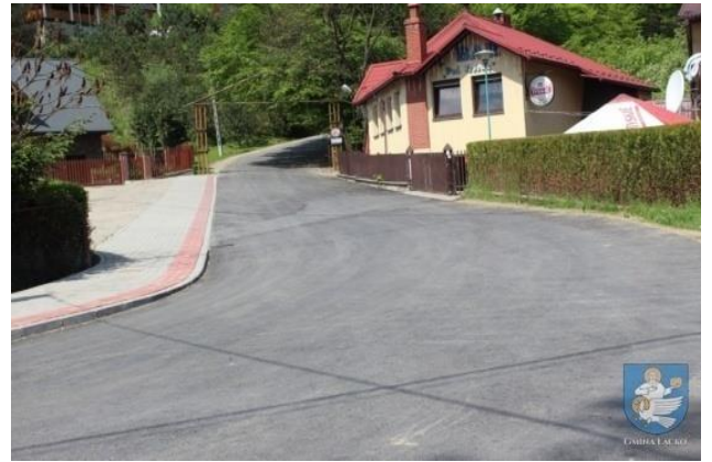
• Zmodernizowano drogę gminną „Łącko – Strażacka”
