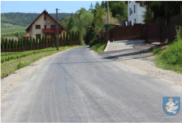
• Zmodernizowano drogę gminną „Łącko – Pożogi”
