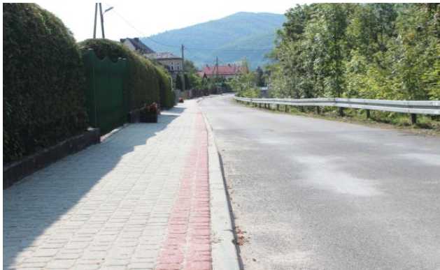
• Remont chodnika na ulicy Nadbrzeżnej wykonany siłami pracowników ZGK w Łącku;
