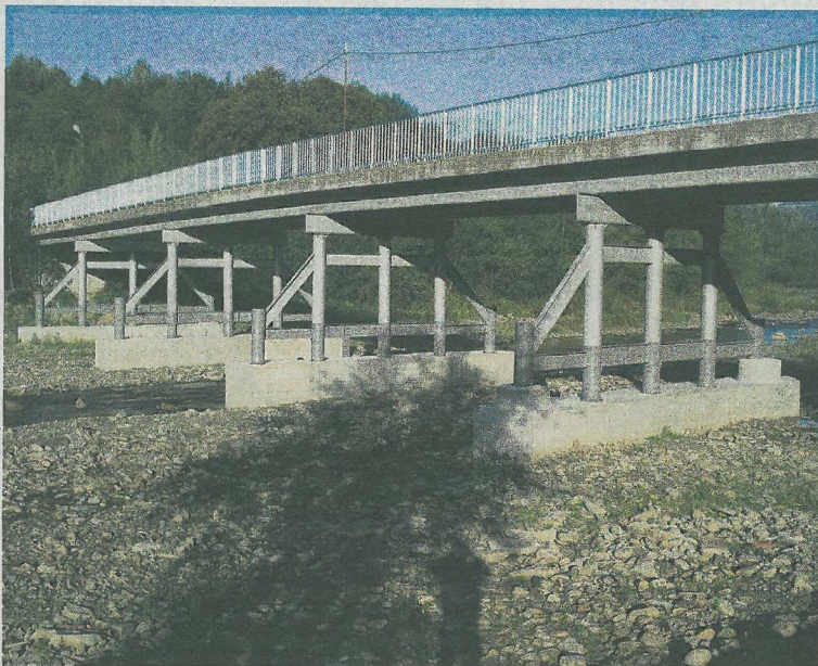
Most na Kamienicy w Zabrzeży odbudowany po powodzi jest teraz w stanie oprzeć się dużej wodzie
