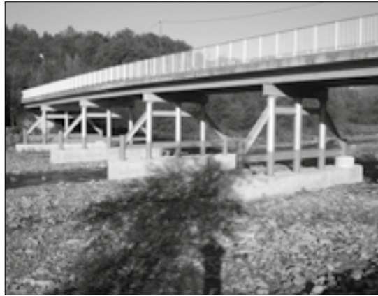
Odbudowa mostu na rzece Kamienica w Zabrzeży
