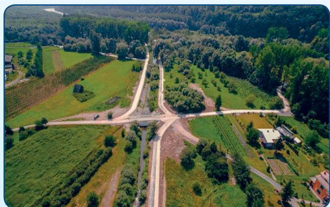
Ścieżka pieszo-rowerowa nad Dunajcem
