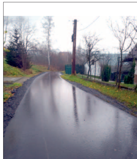
Remont drogi gminnej Łązy Brzyńskie – Pod Prehybę w m. Łązy Brzyńskie
