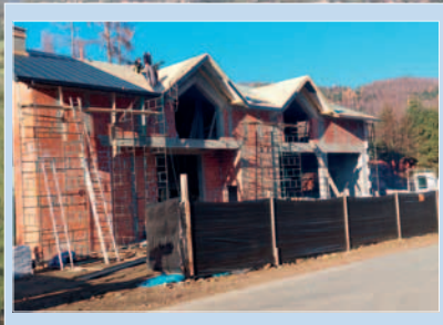
Budowa Budynku Wielofunkcyjnego w m. Obidza
