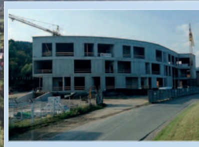
Budowa Centrum Kultury i Edukacji Muzycznej w Łącku
