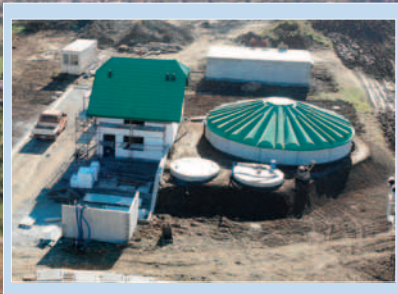
Budowa oczyszczalni ścieków w m. Kadcza
