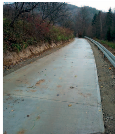
Remont drogi gminnej Zabrzeż – Kluczniki w m. Zabrzeż
