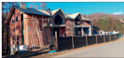
Budowa Budynku Wielofunkcyjnego w miejscowości Obidza
