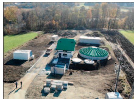
Budowa oczyszczalni ścieków w Kadczy
