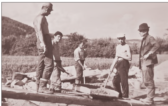
Budowa domu w Zarzeczcu, 1971 r. (fot. ze zbiorów Marcina Brzózki)
