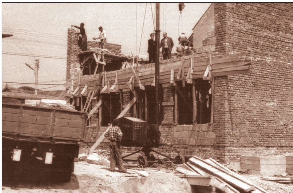
Budowa spółdzielczego Banku Łąckiego l. 60 XX w.
