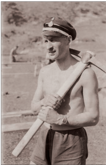
Por. Stanisław Mazan podczas rozbudowy remizy OSP w Łącku – lata 40. (ze zbiorów Rozalii Plechtowej)
