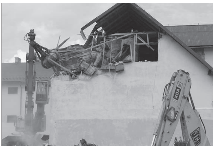
I etap budowy, wyburzanie przybudówki
