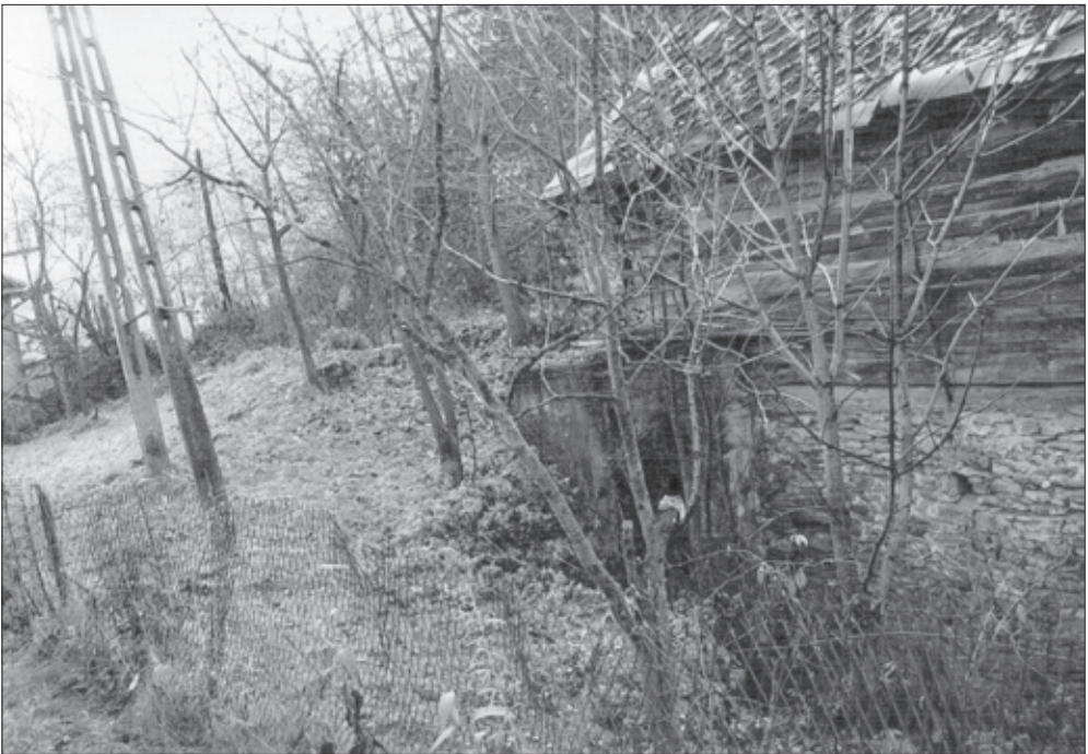
Budynek młyna Tokarczyka, widoczne miejsce, gdzie znajdowało się koło wodne, stan z ok. 2000 r. Fot. Archiwum rodziny Tokarczyków z Brzyny
