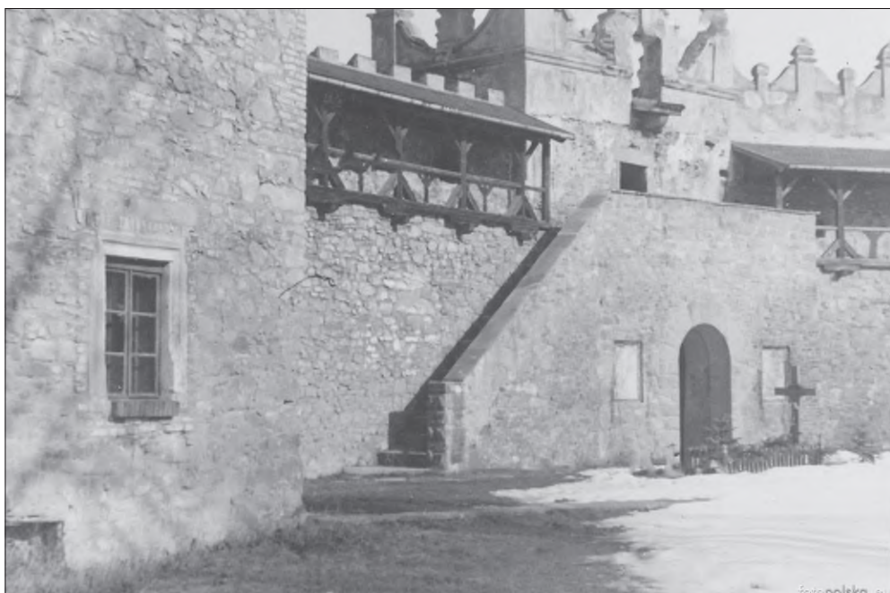
W tle zniszczone przez niemieckiego okupanta tablice poświęcone żołnierzom poległym w walkach w latach 1918–1920
