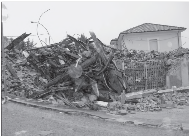
Los domu bez konstrukcji antysejsmicznej
