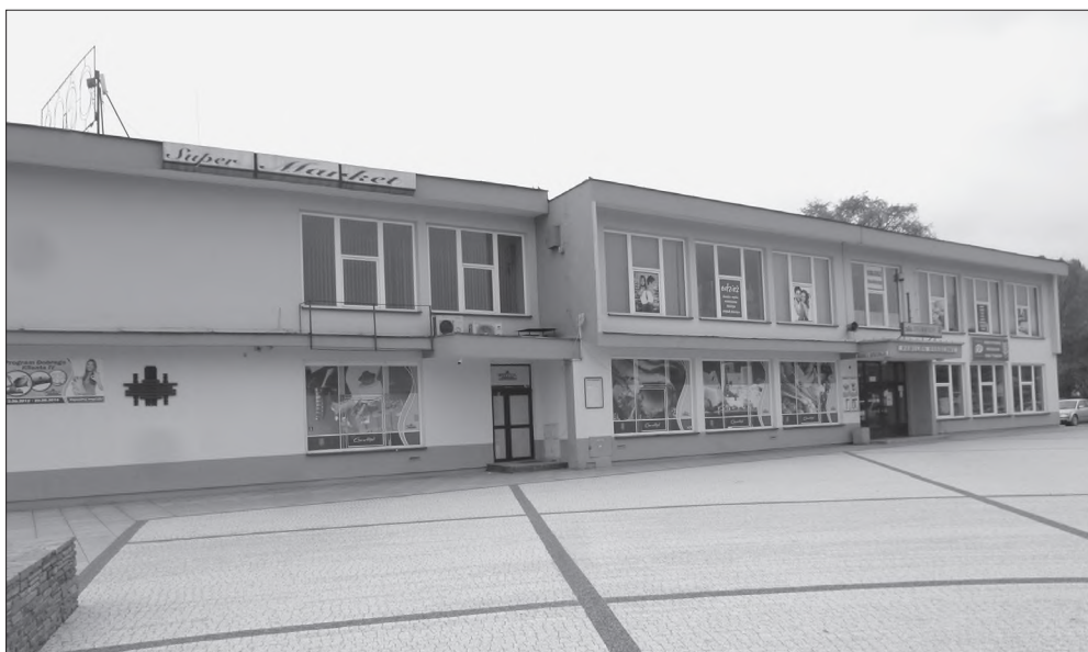
Budynek pawilonu GSu w Łącku, kwiecień 2016 r.
