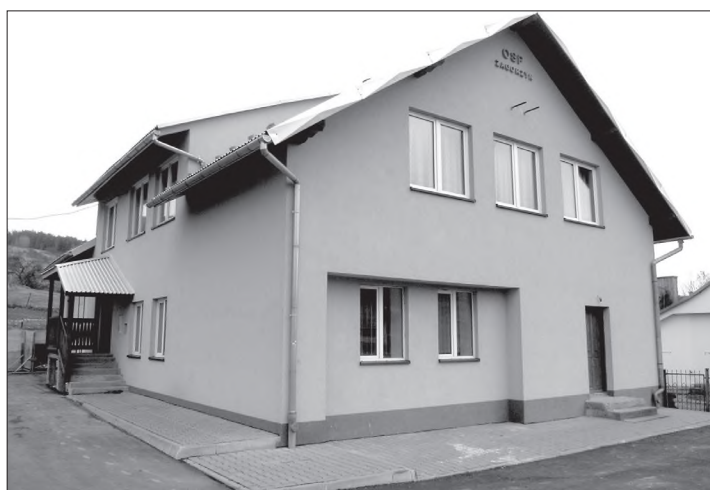
Budynek remizy OSP w Zagorzynie
