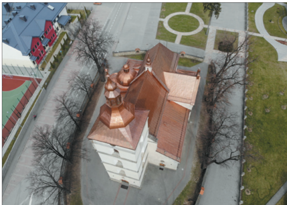
Widok na kościół i wieżę po remoncie dachu – fot. Tomasz Gierczyk
