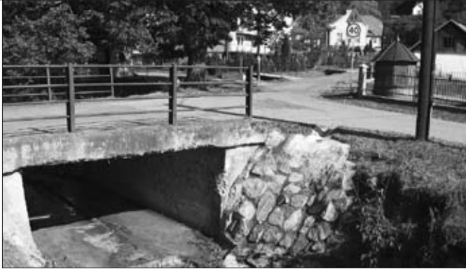
Odbudowa podpory mostu w Maszkowicach
