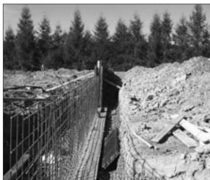
Budowa boiska Orlik w Łącku
