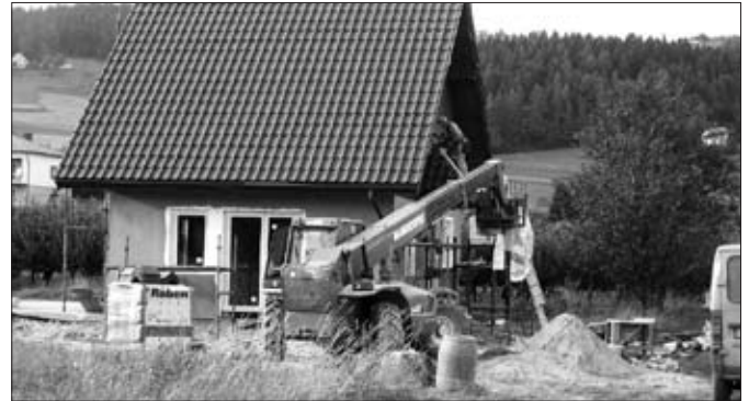
Odbudowa domu w Jazowsku
