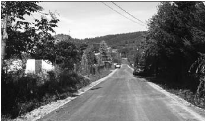
Odbudowa drogi osiedle w Jazowsku
