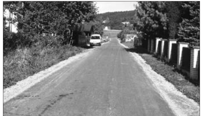
Odbudowa drogi osiedle w Jazowsku
