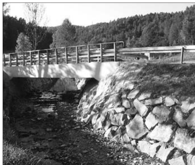
Odbudowa mostu w Kadczy
