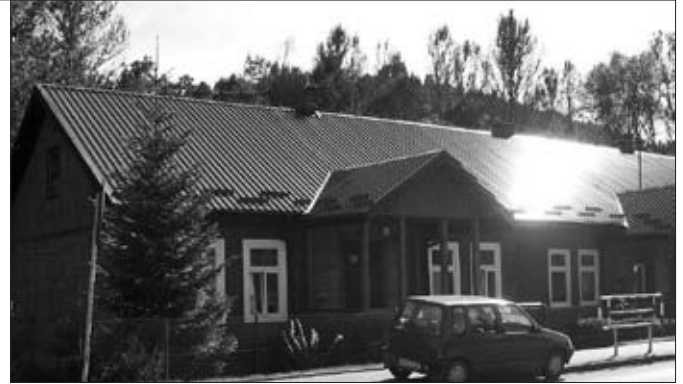
Wymiana pokrycia dachu przedszkola w Jazowsku
