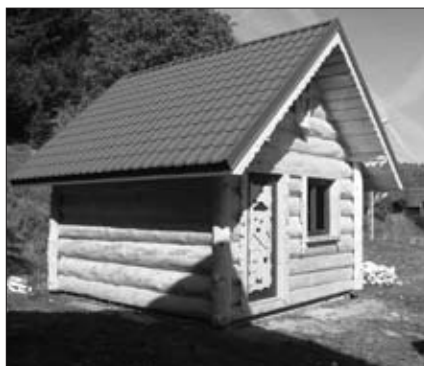
Budynek przy amfiteatrze
