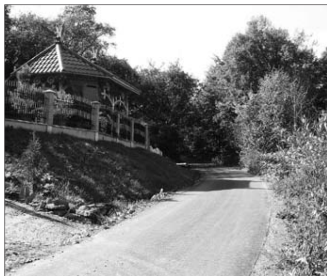
Odbudowa drogi w Brzynie
