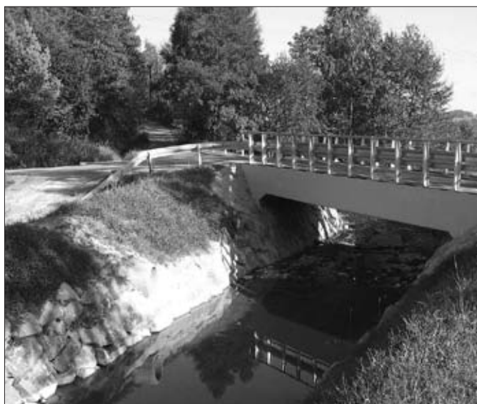
Odbudowa mostu w Kadczy
