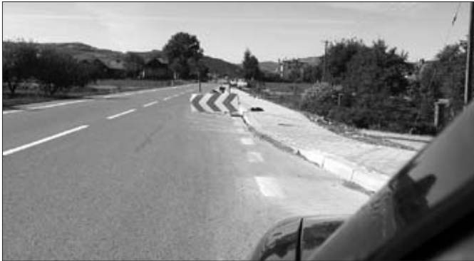
Chodnik Łącko – Maszkowice
