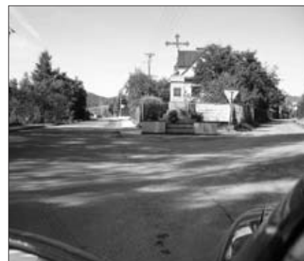
Budowa chodnika w Łącku
