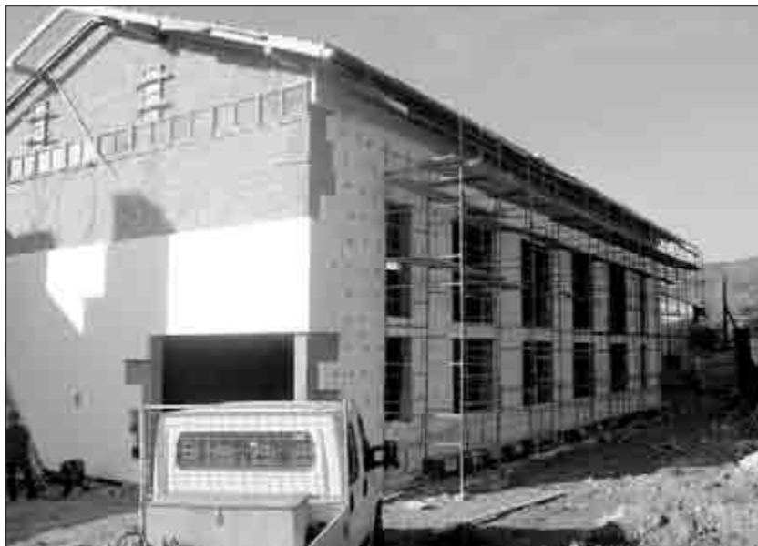
Nowa sala gimnastyczna w budowie
